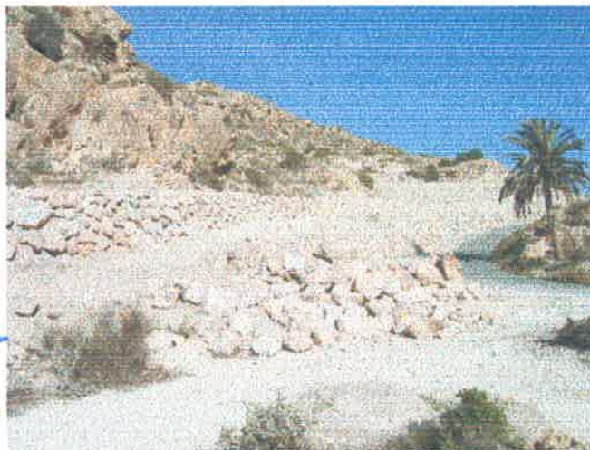
Actuaciones de desmonte en ladera Este.
