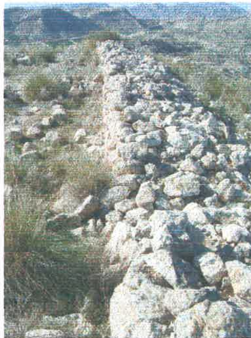
Restos de la Muralla.
