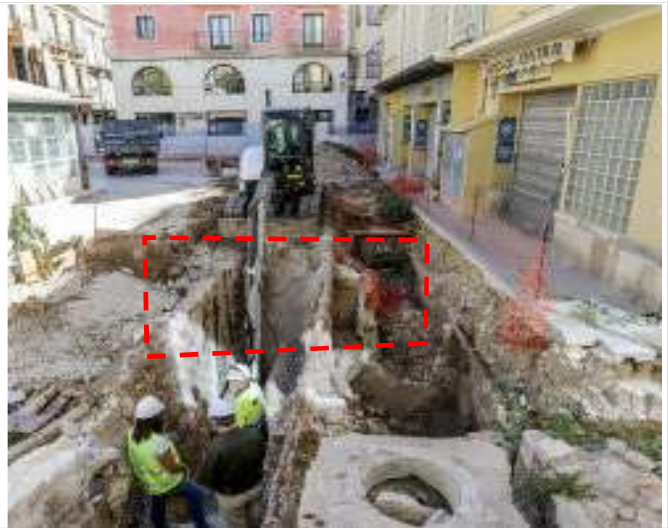
Vista general acceso
