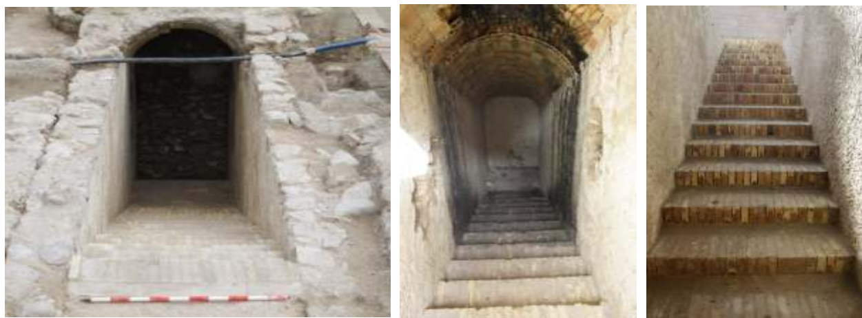
Img. 9.- Escaleras de peldañeado de ladrillo macizo de acceso al refugio.
