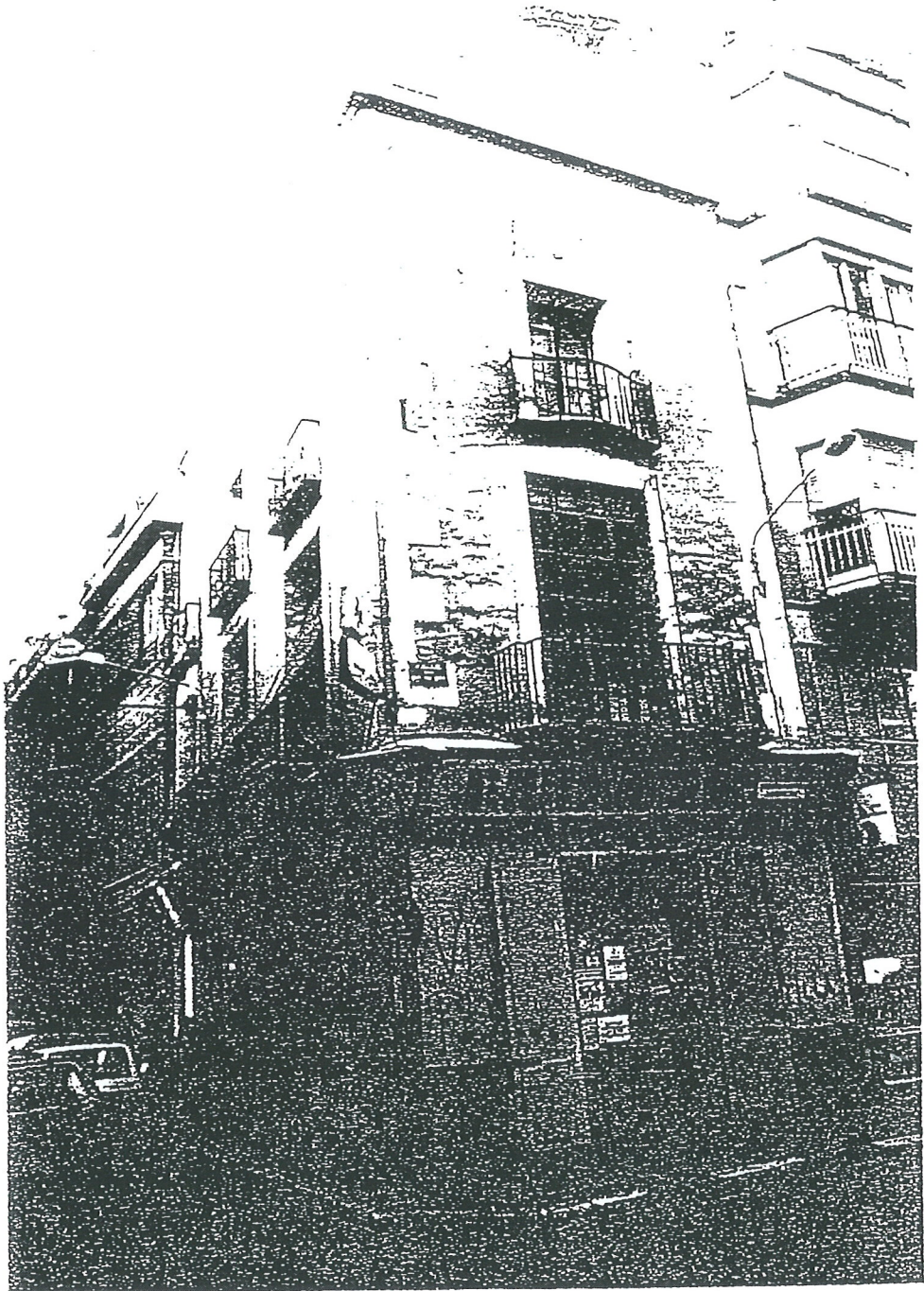
Fachada a c/ Aureliano Ibarra.
